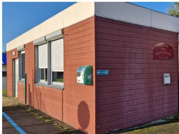
Fuite rue de la vallée
